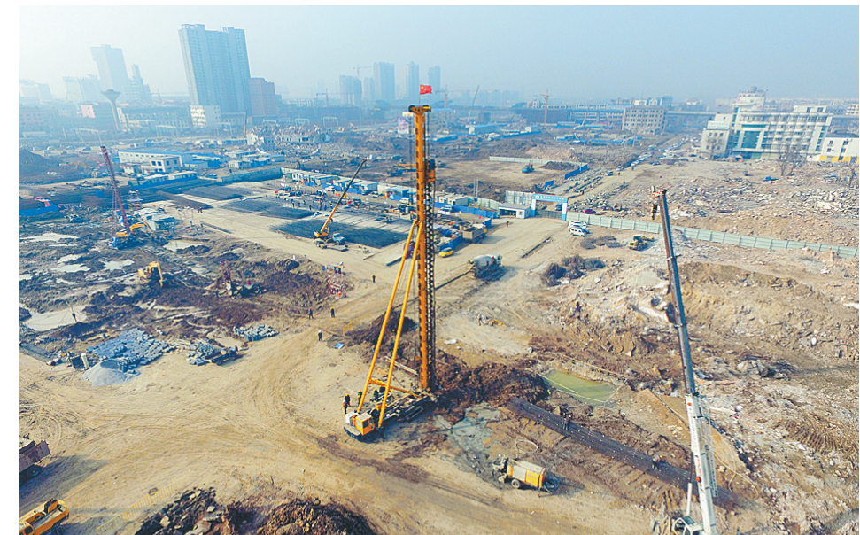
建设中的高铁站前广场
