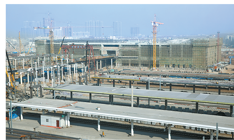
高铁站房主体工程已经完工
