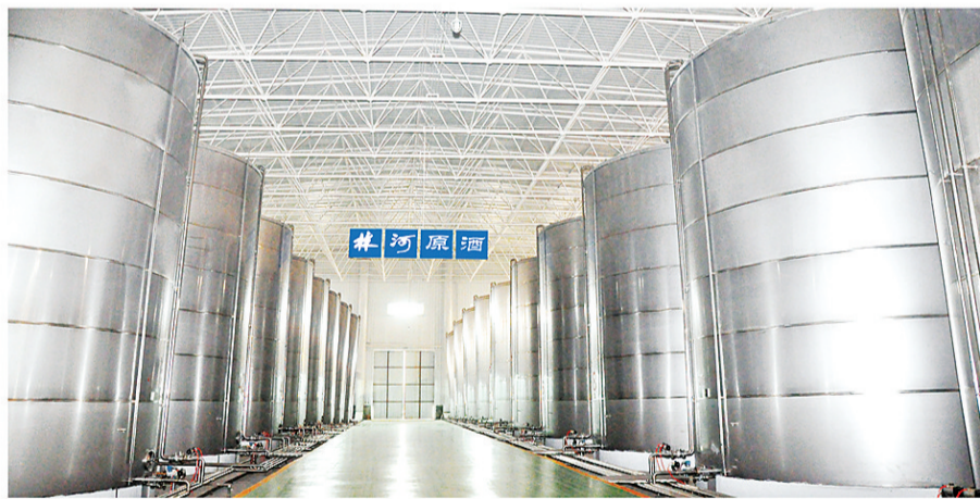
5000吨原酒储藏中心一期工程
