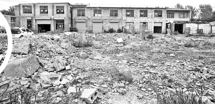
睢阳区柳王庄村拆迁垃圾未覆盖。
