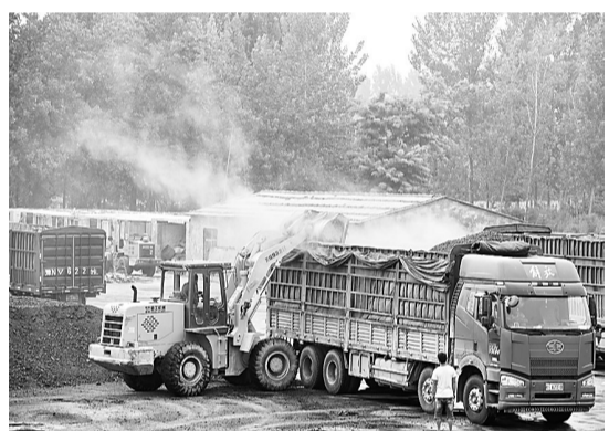
在商丘城乡一体化示范区商都大道与通达八路交叉口东北角的一处内，工程车装卸时冒出浓浓灰尘。
