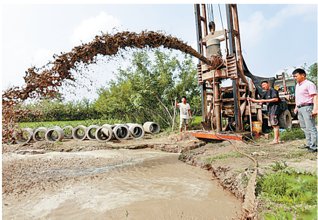
7月5日,宁陵县水务局打井队在柳河镇张庄村打深井。该县房管局驻村扶贫工作队为增加农业后劲、争取扶贫农业项目,积极联系县水务局打井队为群众打深井,增加农业有效灌溉面积,现已打深井15眼,深受群众欢迎。
