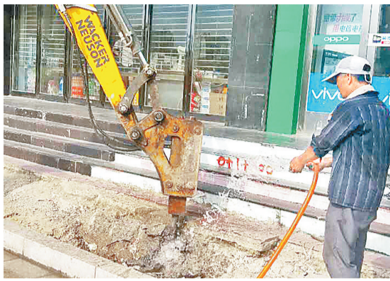
7月30日上午,工人正在洒水降尘施工。为保证归德路升级改造工程施工如期完工,市市政工程总公司按照相关要求,施工现场设置围挡全封闭,并安排专人监督洒水降尘施工。 本报记者 高会鹏 摄
