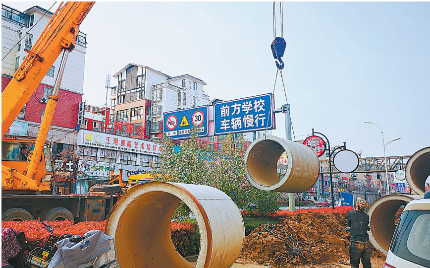
4月11日,夏邑县住建局施工队在孔祖大道埋设污水管道。今年以来,该县实施孔祖大道等9条道路雨污分流工程,完成7条主次干道混错节点改造,完善城市防洪排涝设施。 本报融媒体记者 韩丰 摄
