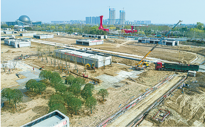
4月10日,建设中的城市森林公园项目。总投资2.8亿元的商丘城市森林公园项目位于“商丘好人”主题公园南侧,占地面积460余亩,是集休闲、科普教育、文化健身、生态保护等功能于一体的综合性公园。目前该项目正在进行地上绿化施工。 本报融媒体记者 崔坤 摄
