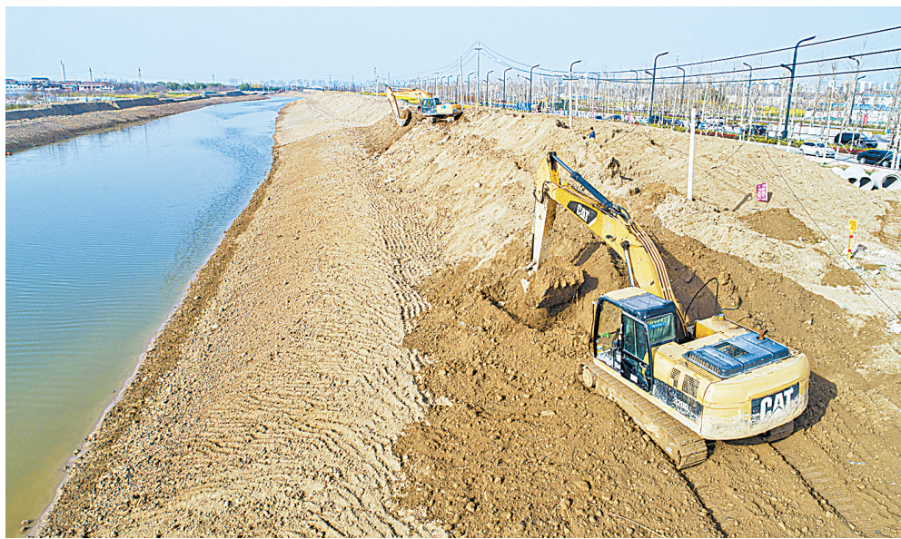
4月17日，大型机械在睢阳区古宋河治理施工现场作业。入春以来，我市水利部门抢抓春季河道治理施工有利时机，加紧推进古宋河治理工程项目，全面开展河道清淤疏浚工作。本报融媒体中心记者 崔坤摄
