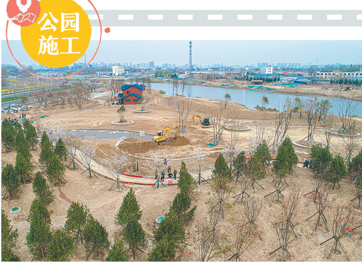
4月20日,大型机械在周商水运河生态湿地公园施工现场忙碌着。该公园长约4.2公里,目前河道清淤及河堤施工已全部完成,正在进行乔木栽植和景观小品建筑施工。本报融媒体记者 崔坤 摄
