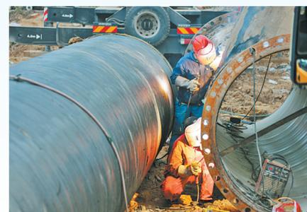
第四水厂原水管焊接安装
