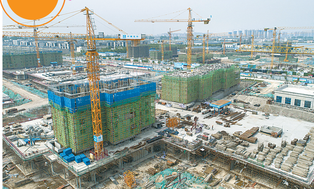
4月24日,在示范区和悦新城二期项目施工现场,一栋栋建筑拔地而起。近年来,我市坚持把安置房建设作为重要民生工程来抓,在保证工程建设质量的前提下,全力推进安置房建设进度,让群众住有所居、住有宜居。 本报融媒体记者 崔坤摄
