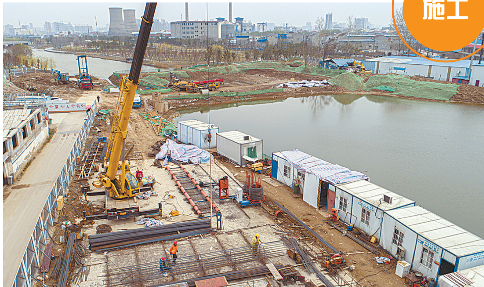
4月24日,施工人员在香君西路运河桥施工现场忙碌着。近年来,我市不断优化交通路网规划,打通“断头路”、疏通“瓶颈路”,持续提高交通综合治理水平,改善城市交通拥堵状况,百姓获得感、幸福感不断提升。 本报融媒体记者 崔坤摄
