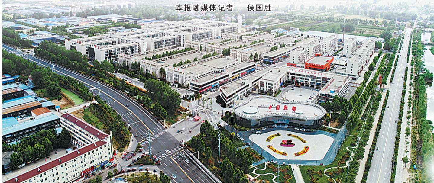
俯瞰睢县制鞋产业基地。徐泽源 摄
