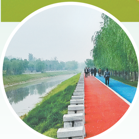
5月17日,睢县城区的利民河带状风仪湖公园,绿草茵茵,湖水清清;亭台轩榭、楼阁相互映衬,水上栈桥、拱桥相得益彰……
