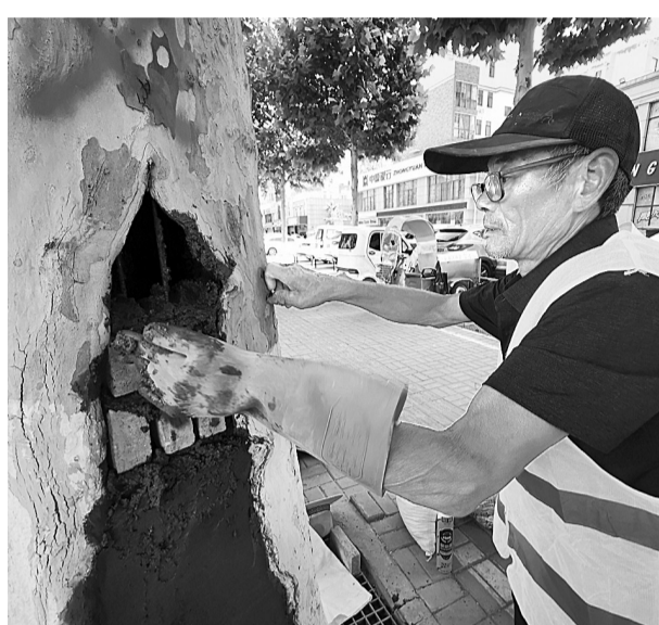
5月31日,市园林绿化中心工作人员在睢阳大道与长江路交叉口东北角,实施法桐树木腐洞修复工作。据悉,园林绿化中心将巡查全市树木情况,并对病害树木进行修复或移除,保证树木健康和城市景观。
