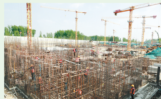
民权县高新区正在建设中的新材料项目工地。 本报融媒体记者 闫鹏亮 摄
