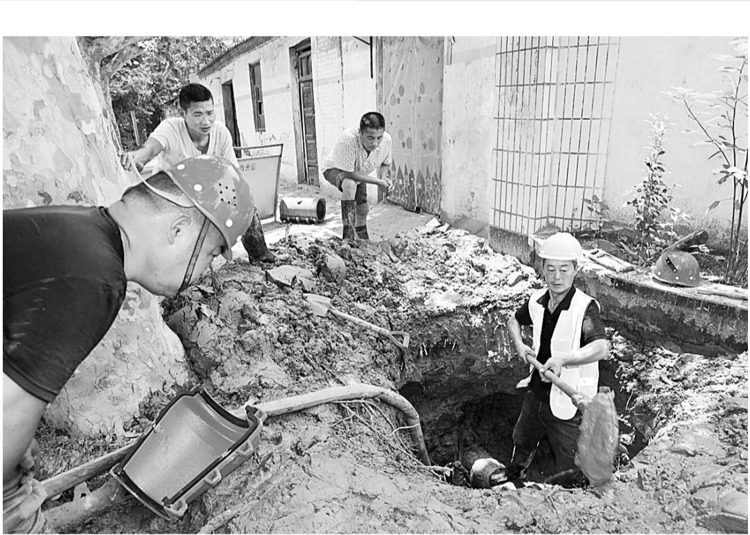
6月21日,市正源水务有限公司工作人员在陇海路自来水输水管道封堵堵点。据悉,入夏以来,我市气温居高不下,市区居民用水量不断攀升。为了确保今年夏季高峰供水安全有序,市正源水务有限公司采取多项措施应对夏季高峰供水,确保市民用水无忧。 本报融媒体记者 邢栋 摄
