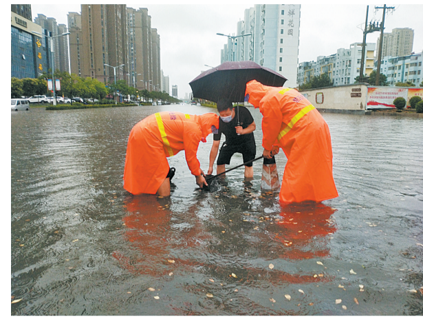
防汛人员及时打开道路两侧雨水箐子,并设置警戒线、清理井口杂物,加大雨水排量。
