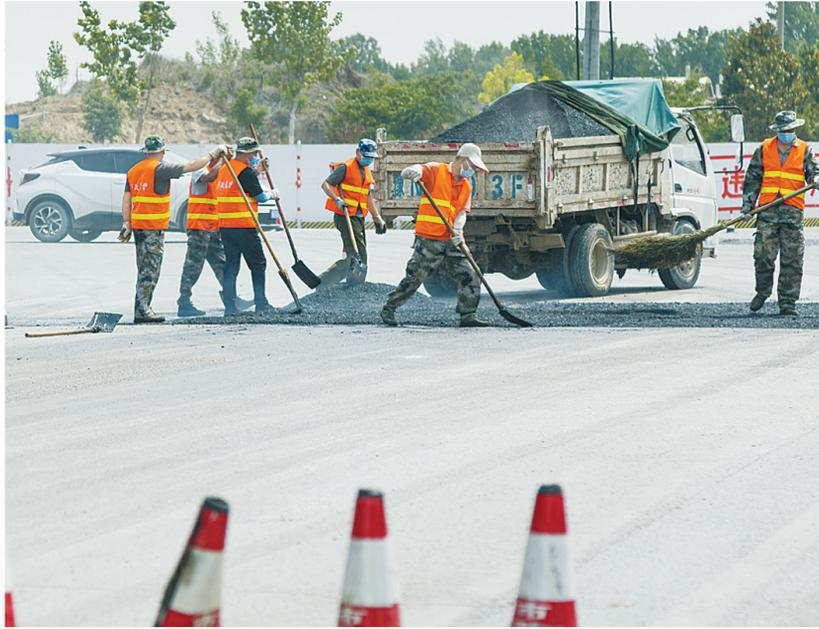
7月1日,施工工人们将对商都大道损毁路面进行修补维护,确保市政基础设施正常运行,为市民营造安全、舒适的道路交通出行环境。
