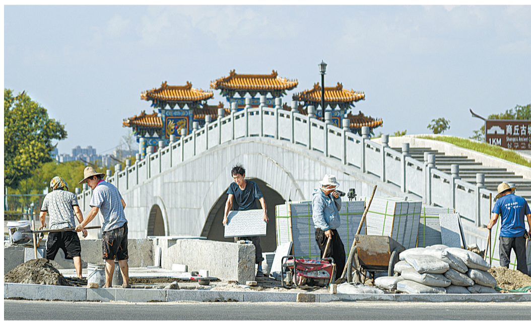
7月10日,在应天西路古宋河桥旁,工人在铺设大理石地砖,刚铺好的一排排整齐的地砖让道路颜值提升不少。 本报融媒体记者 崔坤 摄
