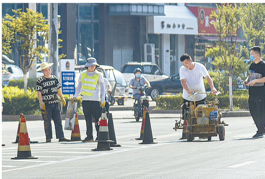
7月10日,施工人员在长江路与华夏路交叉口施划道路标线,规范交通秩序,保障市民安全出行。 本报融媒体中心 崔坤摄
