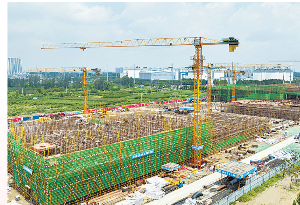
8月2日,建设中的商丘集美数智产业园项目(无人机照片)。该项目位于梁园区黄河路与建设西路交叉口西北角,一期投资20亿元,规划打造成集研发、孵化、生产、销售为一体的商丘5G工业互联网智能新兴数字经济产业园区,年产值可达105亿元。 本报融媒体记者 崔坤摄
