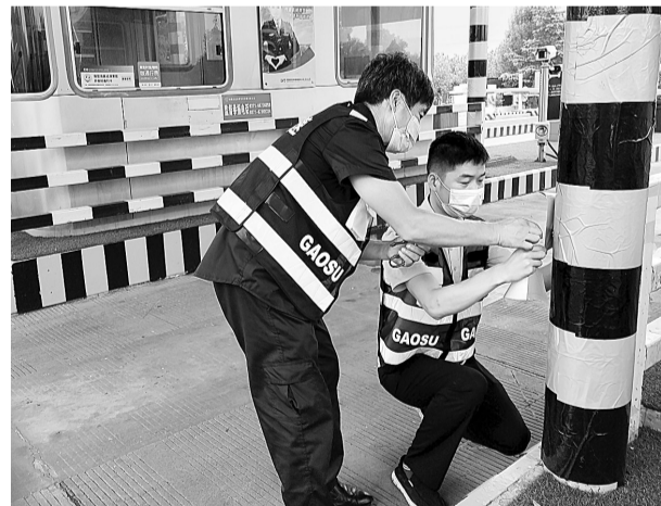
8月16日,商丘高速永城南站员工在修补一处破损的防撞柱。长期以来,该站坚持落实日常安全隐患排查制度,及时化解风险隐患,确保车辆安全畅通。李帅兵 摄
