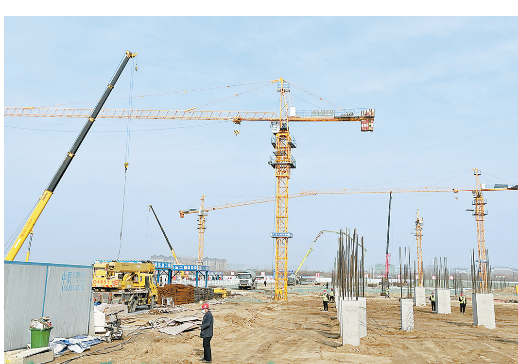
2月14日,商丘电商物流园项目正在施工中。该项目位于虞城县,总投资50亿元,规划建设10栋快递分拣中心高标准物流仓储,全部建成后可入驻互联网及电子商务企业150家以上,年交易额达120亿元。 本报融媒体记者 崔坤 摄
