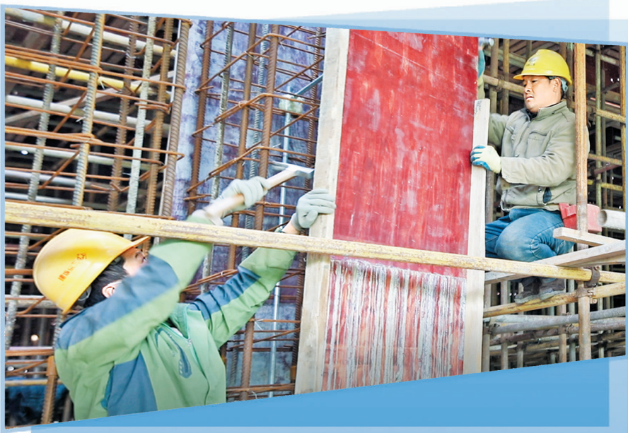
柘城县产业区内,工人正在施工。本报融媒体记者 蒋友胜 摄
