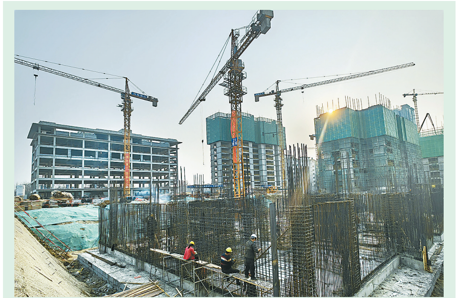
3月2日，在珠江路与九州路交叉口西北角睢阳区敬老院项目建设现场，1号楼主体已经完成，工人正在对2号楼负一层墙柱进行钢筋绑扎。该项目是商丘市政府“十四五”规划重点项目，占地17.8亩，规划建筑面积22152平方米，设置养老床位500张。
