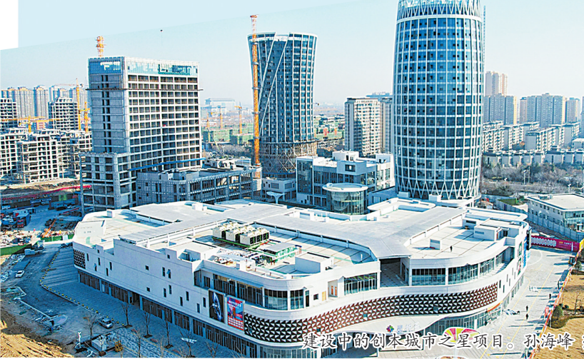
建设中的创本城市之星项目。孙海峰 摄
