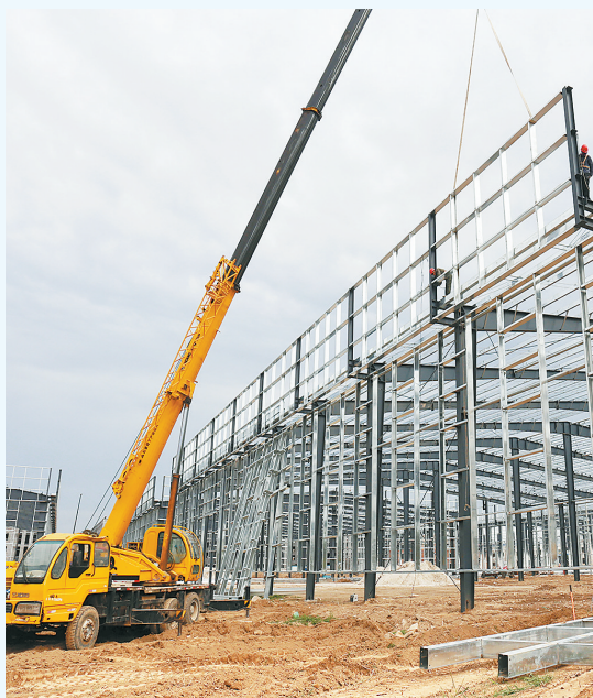
位于睢阳区的河南中科合创产业园的生产厂房正在加紧建设。 本报融媒体记者 邵群峰 摄
