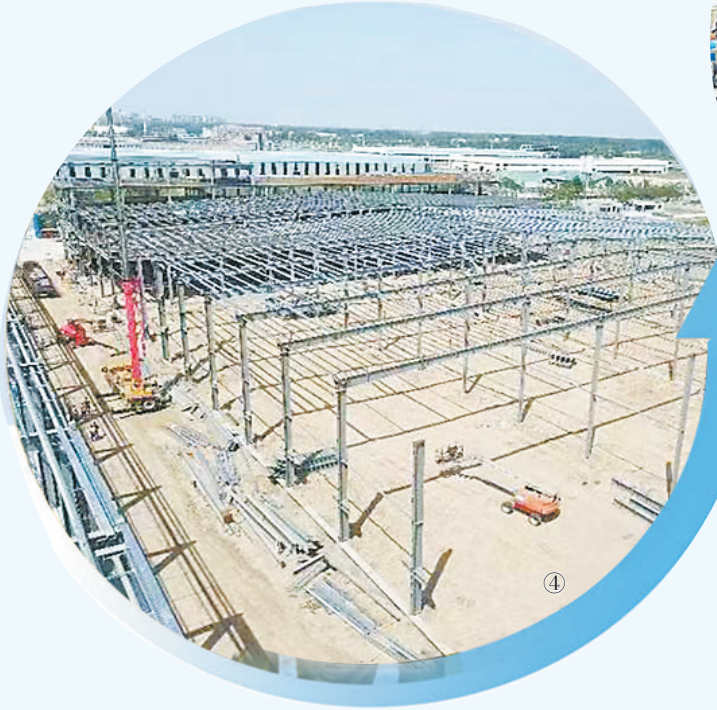
►夏邑县5万台轻跑新能源汽车项目 自动化生产车间正在紧张施工中。 本报融媒体记者 韩 丰 摄
