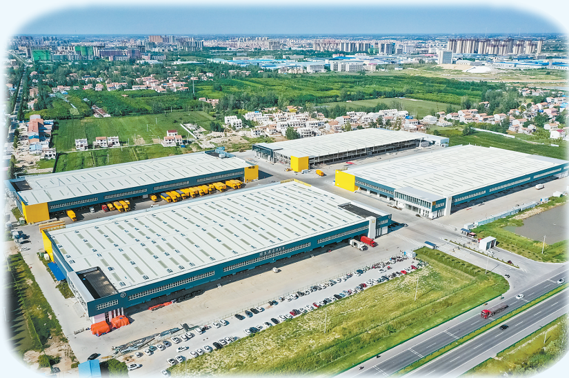
虞城县电商物流产业园。 本报融媒体记者 刘建说 摄
