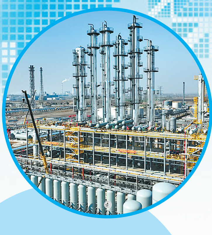
图1:永城经开区河南瑞柏新材料一期项目正在施工中。 刘家均 摄
