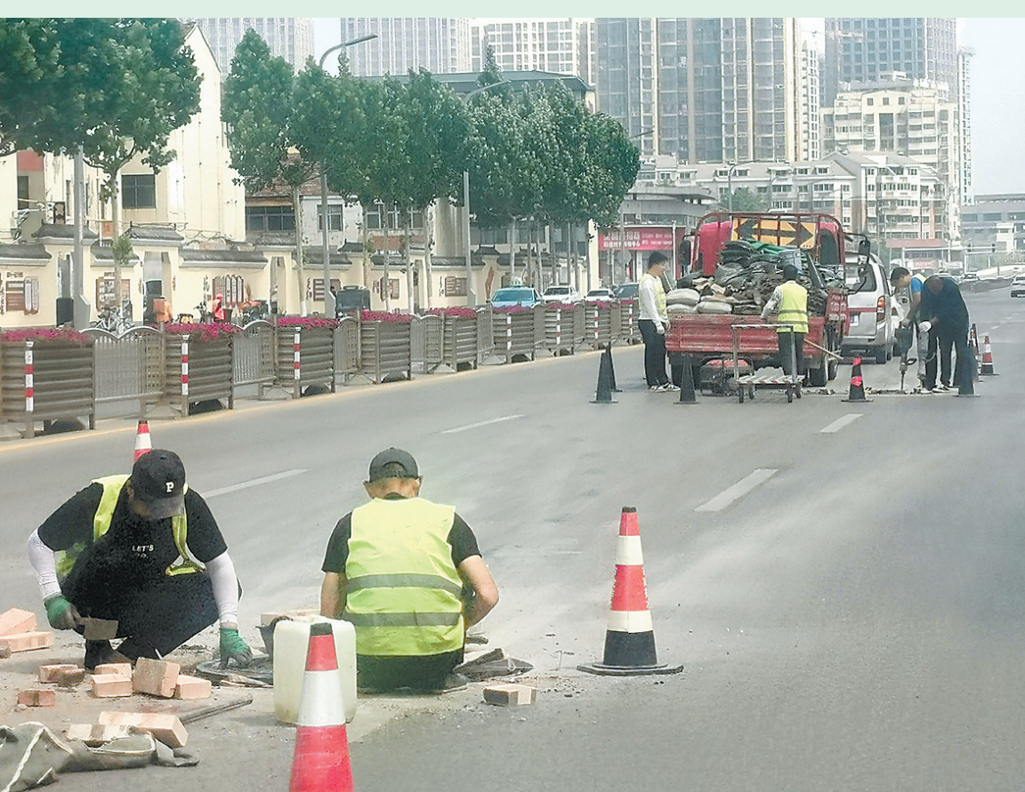
5月25日，市区归德路中段，市政工作人员正在对井盖进行升级维修。为确保强降雨期间群众出行安全，市政管理部门近日开展了全市井盖设施隐患排查整治行动。
