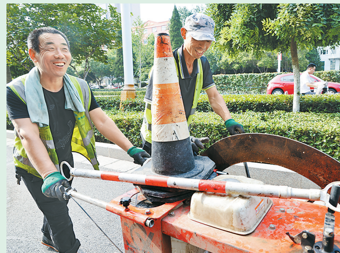
7月10日，天气酷热难耐，市城管局工作人员在南京路进行井盖更换作业，确保主汛期雨水流通顺畅。本报融媒体中心记者 邢栋 摄
