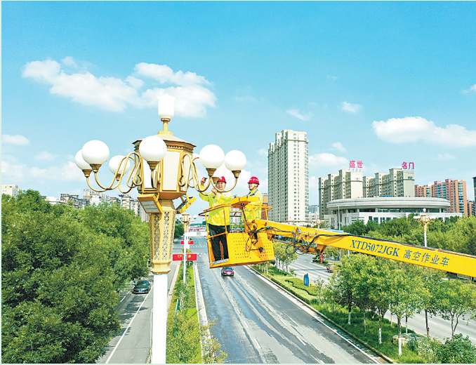
7月18日，民权县城管局亮化服务中心的员工冒高温酷暑在高空作业维修高杆灯。这几天，天气酷热难耐，人们大都猫进空调屋里纳凉。民权县各行各业室外劳动者不畏高温酷暑，在各自的岗位上挥汗如雨，默默奉献。
