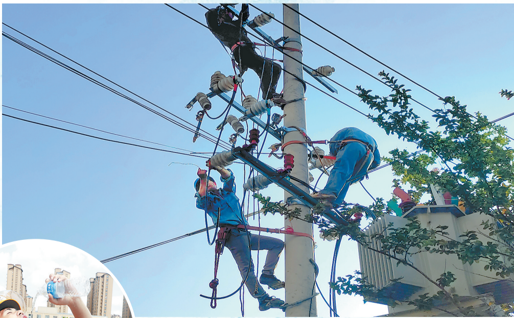
▲7月24日,国网宁陵县供电公司工作人员克服高温天气,对县城小区变压器增容、升级改造,确保居民安全用电。 吕忠箱 摄
