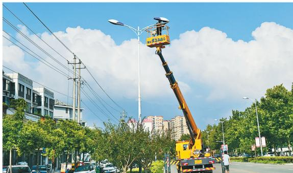
7月31日,国网夏邑县供电公司施工人员在抢修路灯。近几天连续降雨,部分路灯线路短路,技术人员冒高温及时抢修,确保夜间照明。
