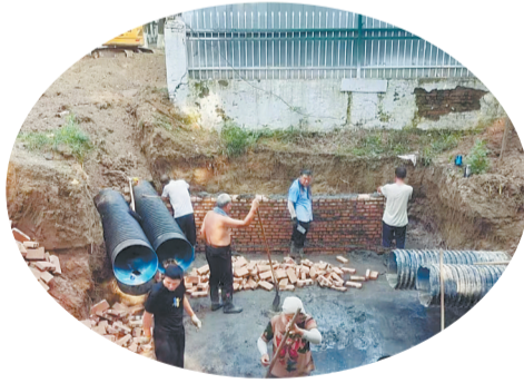
下水道施工现场。 本报融媒体中心记者 邵峰峰 摄
