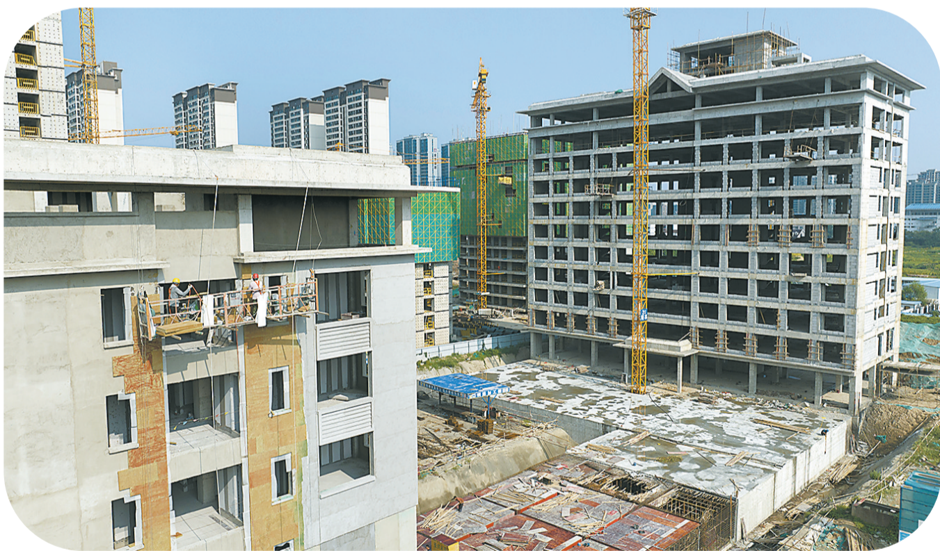
8月14日，工人在睢阳区敬老院项目施工现场忙碌着。该项目位于珠江路与九州路交叉口西北角，占地面积17.8亩，规划建筑面积22153平方米，设护理床位500张，是集综合养老、康复服务、重度残疾人照顾于一体的综合性养老服务机构。
