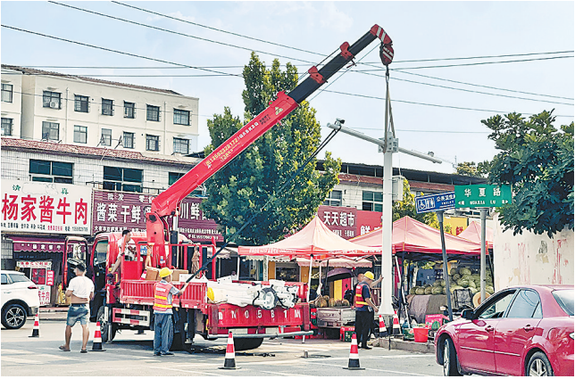
8月15日,施工人员在华夏路与宜兴路交叉口安装智能交通监控设施,进一步完善背街小巷道路监控系统,改善群众出行环境。 本报融媒体记者 崔坤摄
