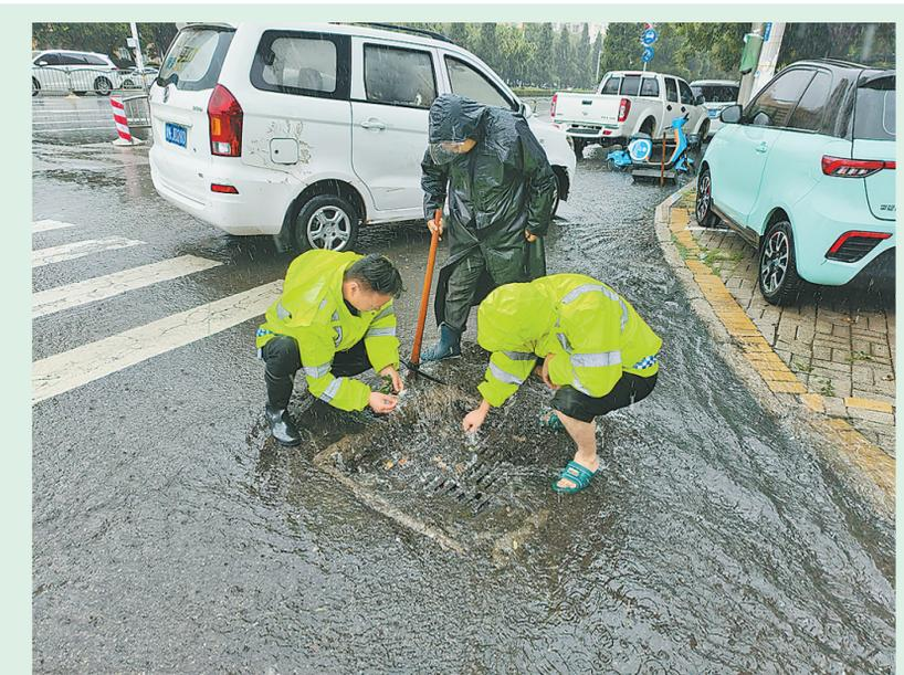
8月27日，受持续性强降雨影响，城区内部分低洼路段排水口被落叶、泥沙等杂物堵塞，造成积水现象。睢阳区城市管理局组织执法人员冒着大雨，抢时间奋战在街道一线，疏通及清理下水道，确保街道水算子雨水通畅，严防城市内涝，排除安全隐患。
