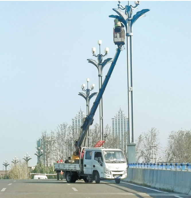
11月2日，市政管理工作人员在归德北路对两侧路灯进行检修维护。据悉，市政管理部门抢抓秋冬季路灯养护黄金窗口期，对主城区内路灯设施进行大排查、大检修，进一步提升路灯设施的照明率、完好率。 本报融媒体记者 邢 栋 摄
