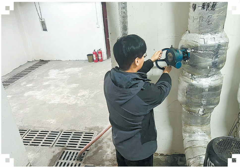
河南省恒源热力股份有限公司工作人员在海亚金城华府小区内调试设备。
