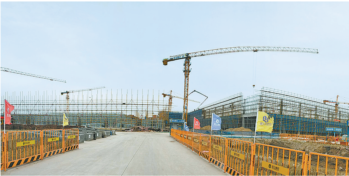
梁园区“三个一批”项目建设呈现快马加鞭、热火朝天的生动局面。
