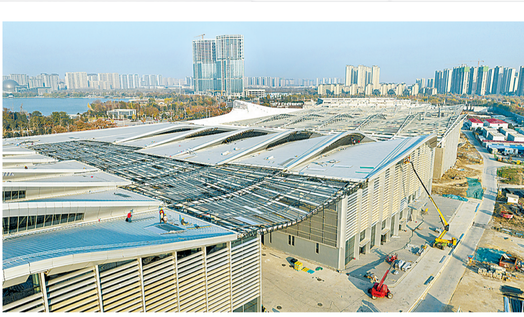
12月17日,建设中的商丘国际会展中心项目。位于日月湖南侧的商丘国际会展中心作为我市标志性建筑,具备展览、会议、餐饮、体育赛事、文娱旅游等功能,建成后将成为我市对外开放的窗口。
