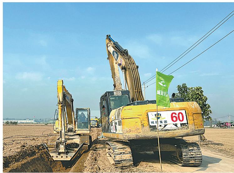
大型机械在高标准农田示范区项目开挖排水渠。
