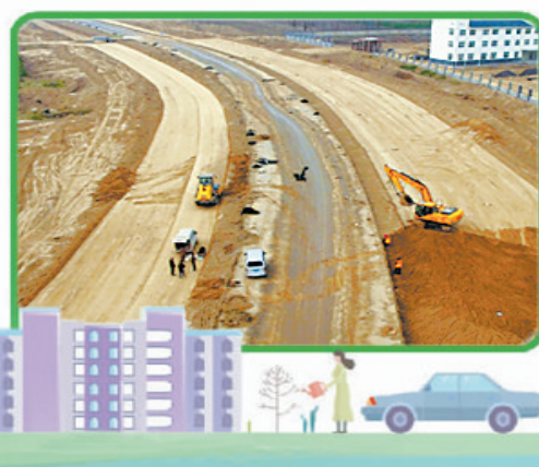
▲睢县环城路拓宽改造施工现场。
