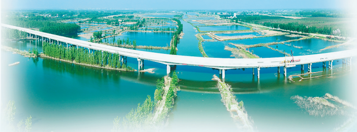
阳新高速黄河故道特大桥跨越民权境内的黄河故道。 本报融媒体记者 闫鹏亮 摄
