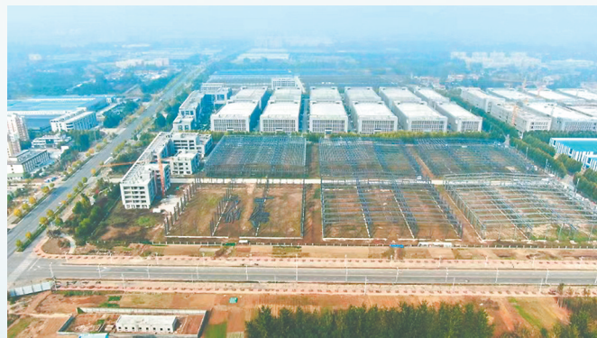
航拍下的柘城县高新区产业园。杨宇 摄
