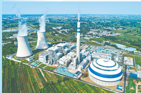
中电(商丘)热电有限公司热电联产机组开足马力保供暖。
