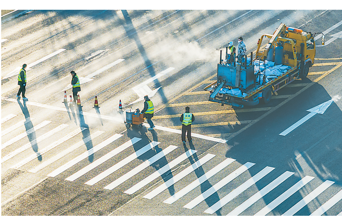
12月29日,施工人员在宋城路进行道路标线施工作业,对道路上存在模糊、缺失等问题的交通标线进行完善,消除道路安全隐患,为市民创造良好的出行环境。 本报融媒体记者 崔坤 摄
