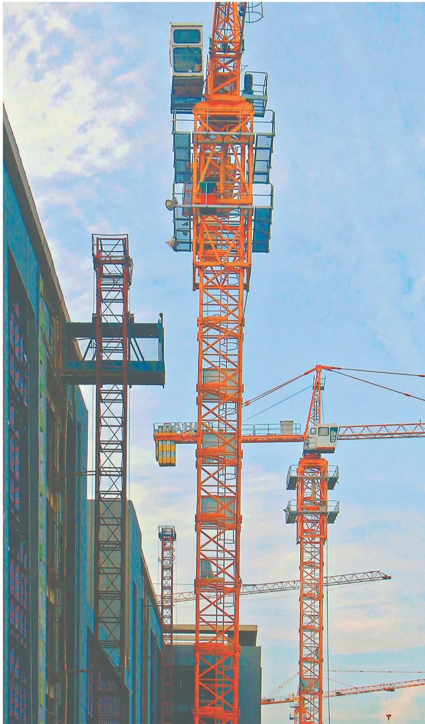
1月2日,柘城县金刚石产业园项目建筑工地,机声轰鸣一派繁忙的施工景象。建筑工人加紧施工,确保生产车间早日投产。 张子斌 摄
