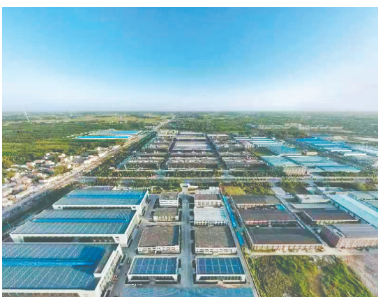
航拍的虞城县智能装备制造园区建设项目。 贾震 摄
