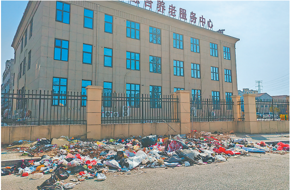
2月17日,位于示范区腾飞路南段的平安综合养老服务中心外墙一侧,垃圾遍地,阻碍交通,有损城市形象。 本报融媒体记者 邢栋 摄
