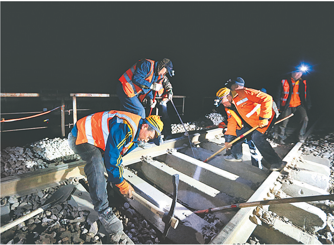
2月24日，铁路职工在陇海铁路甘肃榆中县境内进行桥面人工清筛施工作业。当日，中国铁路兰州局集团有限公司管内陇海铁路进行年内第一阶段集中修。集中修主要进行更换道岔轨件、线路大机捣固、道岔大机清筛、道岔大机打磨等施工作业，全面提升陇海铁路设备质量，保障铁路客货运输安全畅通。
